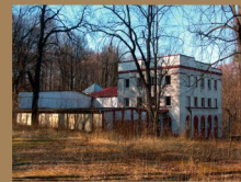
Obecnie najstarszy budynek uzdrowiskowy w mieście stoi w ruinie i czeka na lepsze czasy
