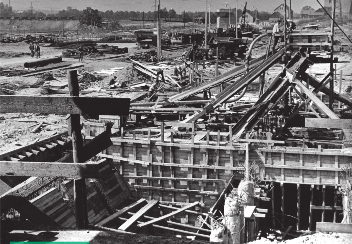
Prace powierzchniowe w pełni. W tle bocznica kolejowa Arch. XXV „Borysław-Zółtanka-Jastrzębie” Rach „Las-Mos”
