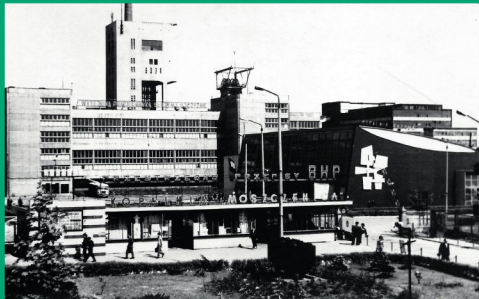
Brama wjazdowa i rejon szachtów głównych Arch. Magdalena Ortaszevska-Wdowiak
