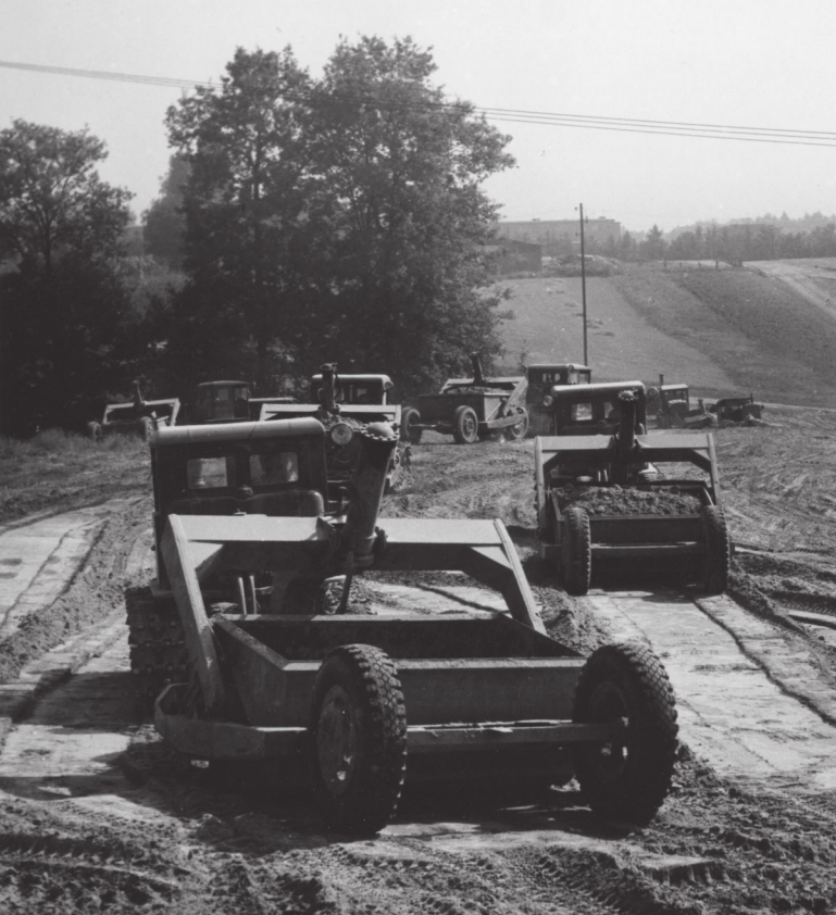
Nivelacja terenu pod budowę kopalni „Mszczonica” Arch. KWN „Barynia-Zielonka-Jastrzębie” Rusz „Jas-Mos”
