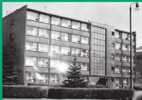
Budynek administracji kopalni Arch. Jerzy Krakowczyk
