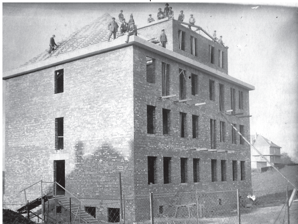
Willa Franciszka w 1930 roku. Ściany gotowe - pora na dach.
