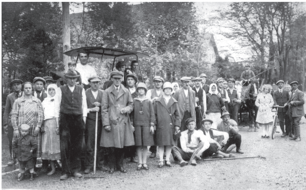
Budowa asfaltowej drogi w Zdroju to dobry pretekst do wykonania pamiątkowego zdjęcia
